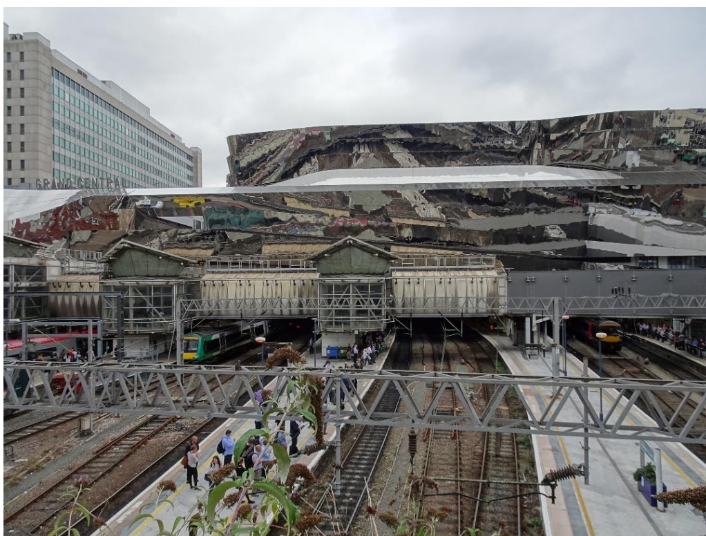
Obrázek 14-4. Hlavní nádraží Birmingham New Street: zrenovovaná „vstupní brána“ do města. Vnější plášť je tvořen lesklými kovovými pláty, které odráží objekty v okolí a opticky zvětšuje prostor.
